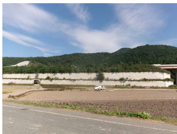
7공구 패널식 옹벽 12
