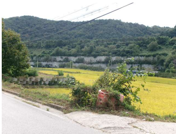
3공구 패널식 옹벽 02
