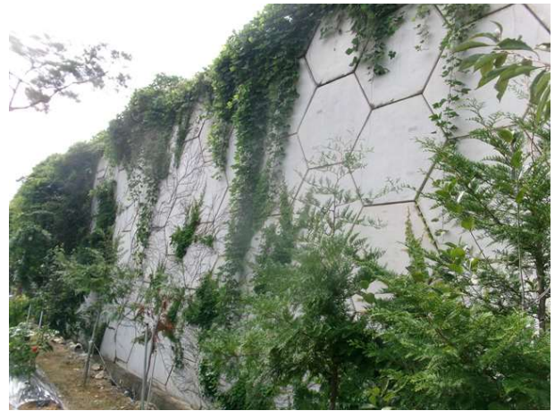
8공구 패널식 옹벽 14
