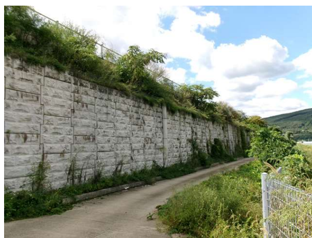
6공구 패널식 옹벽 08
