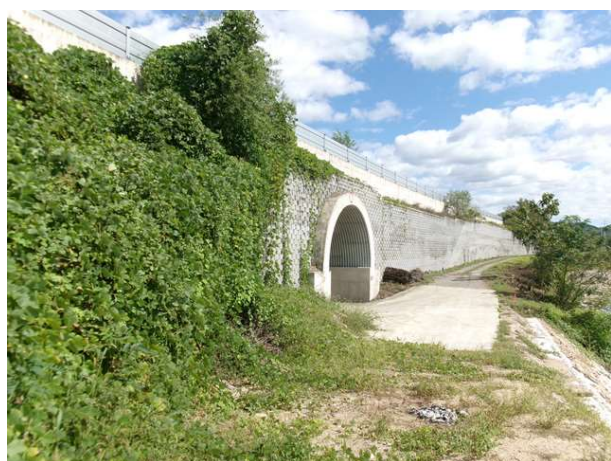
6공구 블럭식 옹벽 09
