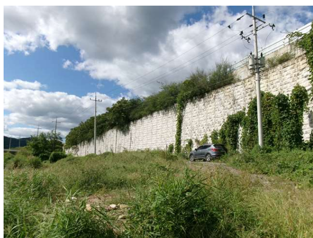
6공구 패널식 옹벽 07
