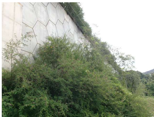
3공구 패널식 옹벽 01
