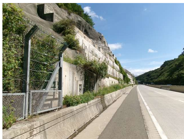
6공구 패널식 옹벽 10
