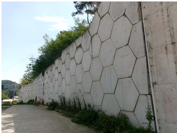
9공구 패널식 옹벽 15
