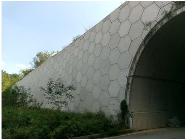
8공구 패널식 옹벽 13
