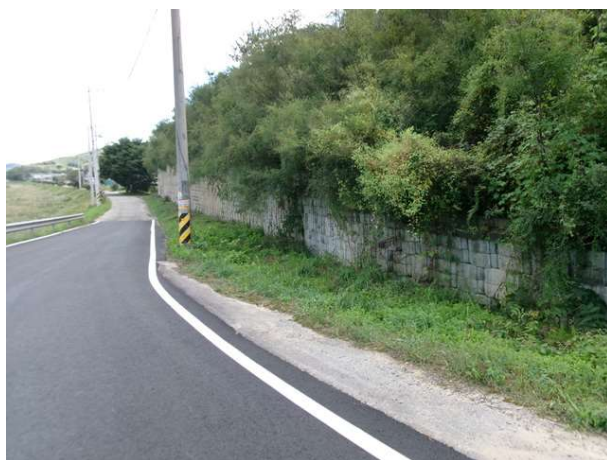
5공구 블럭식 옹벽 06
