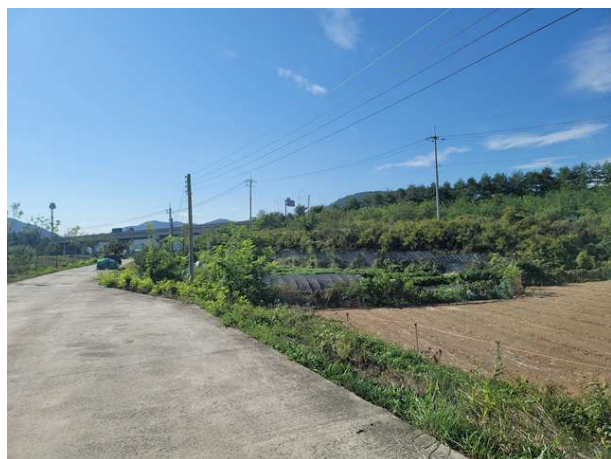
3공구 블럭식 옹벽 03
