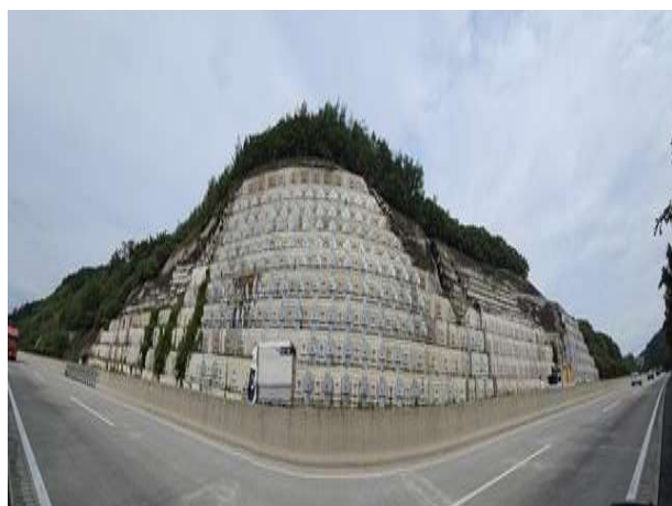
4공구 패널식 옹벽 05
