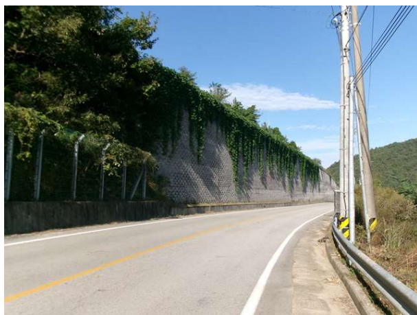
4공구 블럭식 옹벽 04
